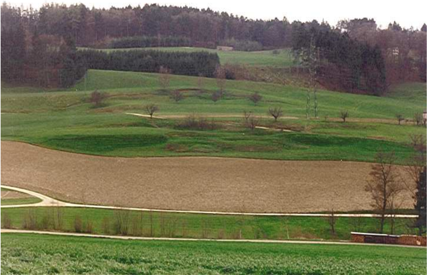
Abb. 1: Ansicht der Rutschung Böbikon, Nordschweiz. Der in der rechten Bildhälfte erkennbare Strommast ist durch die Rutschung direkt gefährdet.
