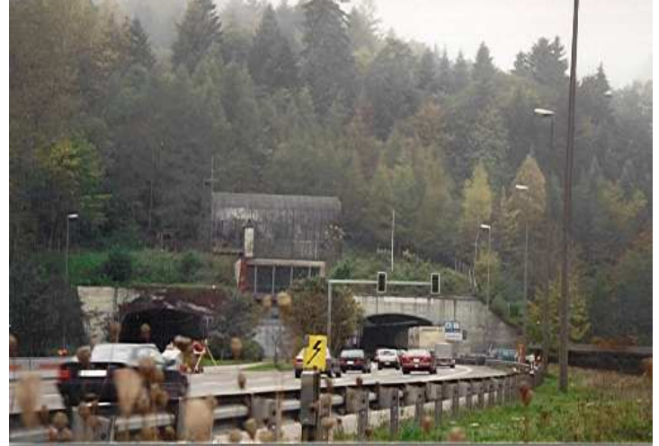
Abb. 1: Westportale der Tunnelröhren
